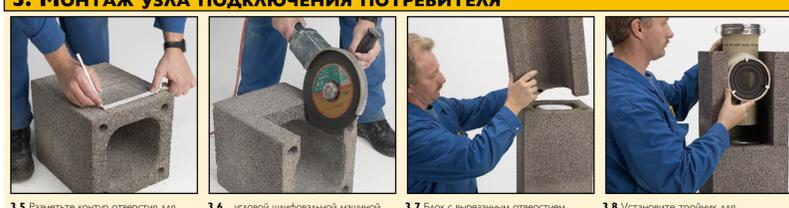
**3.5** Разметьте контур отверстия для подключения потребителя согласно таблице.
