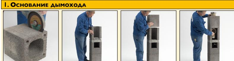
**1.5** На следующем блоке начертите контур отверстия для промывки, размеры которого уточните в прилагаемой таблице. Угловой шлифовальной машиной вырежьте отверстие.
