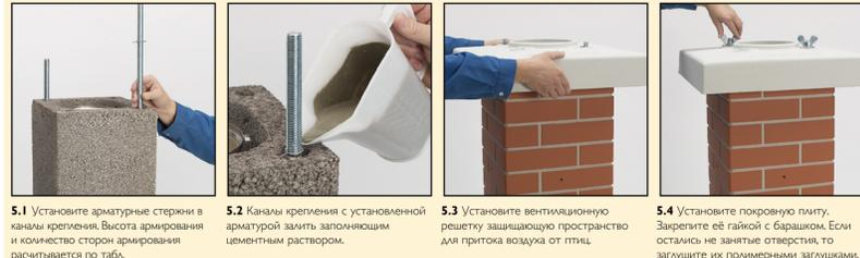
**5.1** Установите арматурные стержни в каналы крепления. Высота армирования и количество стержней армирования рассчитываются по табл.
