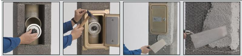
**5.a** Установить тройник (согласно п.3.5 - 3.8). Установите заглушку ревизионного отверстия.
